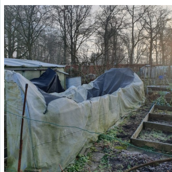
Op de Slottuinen waren een aantal tunnelkassen door het gewicht van de sneeuw ingestort.
